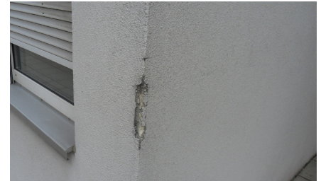
Mechanische Beschädigungen
